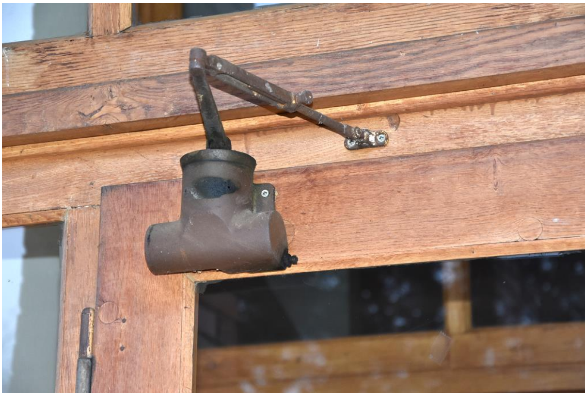
10. ZŠ Dřevnická, detail původního samozavírače „BRANO“.
