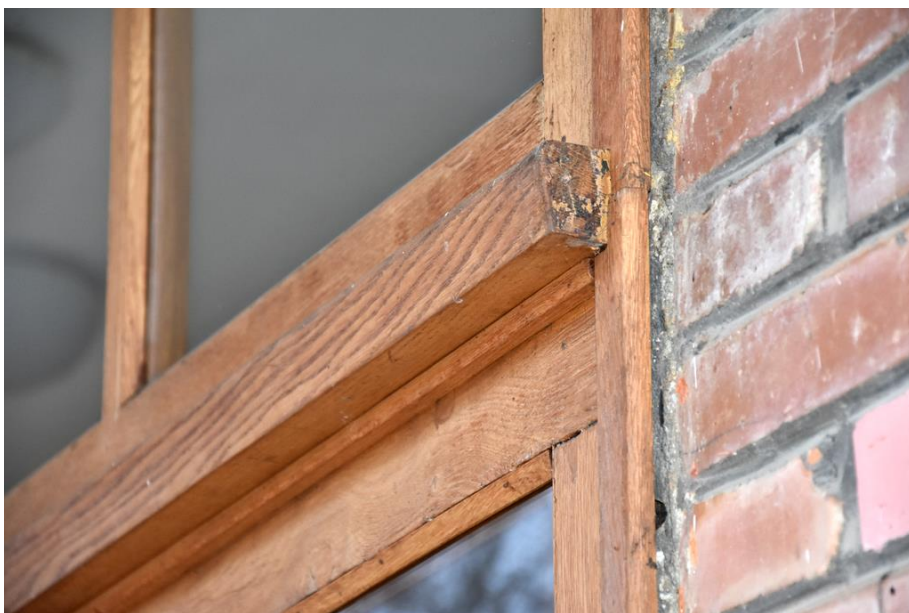
10. ZŠ Dřevnická, hlavní vstup, dodatečné upevnění rámu ke stěně a viditelná spára vnější mezi rámem a ostěním.
