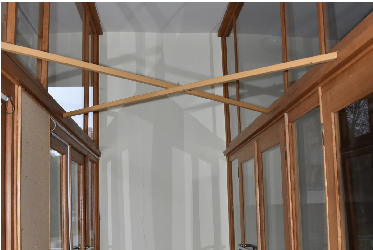
10. ZŠ Dřevnická, hlavní vstup, dodatečné zpevnění stěn dřevěnými příčkami.
