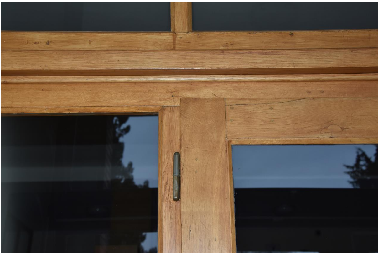
10. ZŠ Dřevnická, hlavní vstup, detail velmi jednoduché profilace konstrukce a původního pantu.
